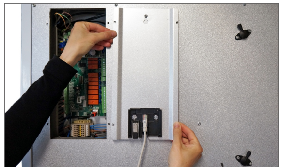
4. Irroita suoja ja ripusta se reiän viereen.
