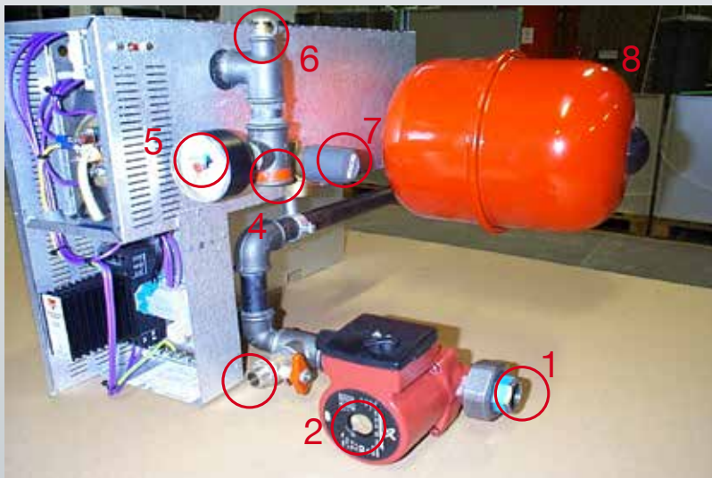
Kuva 22: Sähkökattilan vesikytkentä
