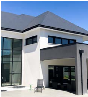
Talo (610m2) lattialämmityksellä ja lämällä käyttövedellä Saint-Prestissä, Ransk.
